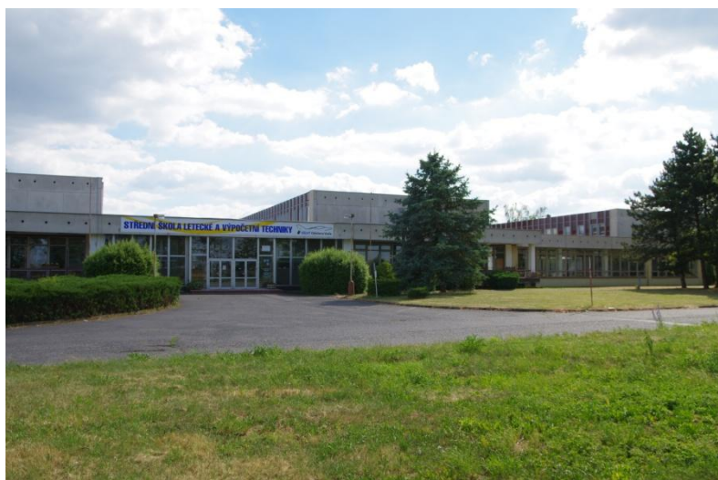
Obr. 2: Celkový pohled na budovu školy
